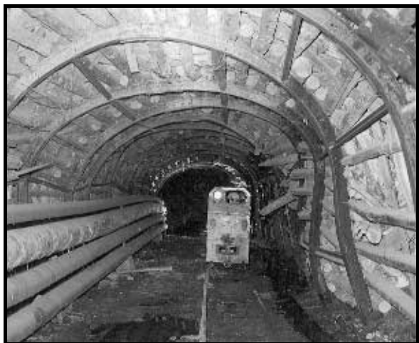
Abb. 2-10-2: Deformation des Stahlbogenausbaus und der Gleislage auf einer der tiefen Sohlen
