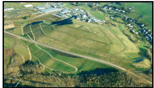
Abb. 5-7: Profilierte, abgedeckte und begrünte Halde und Betriebsfläche 366 mit der Trasse des neuen Autobahnzubringers (S 255)
