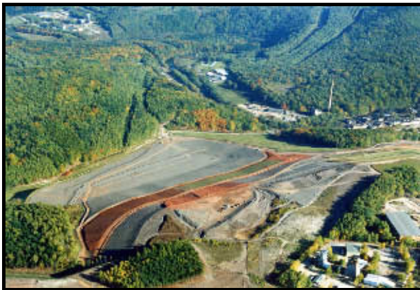
Abb. 5-11: Trockenverwahrtes Absetzbecken mit sanierter Halde Borbachdamm und laufende Abdekarbeiten an der Halde 382 (Stand 2003)
