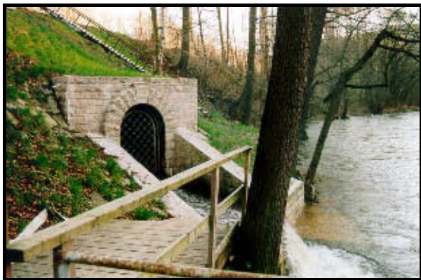
Abb. 5-5: Mundloch der Abflussrösche der Wasserbehandlungsanlage
